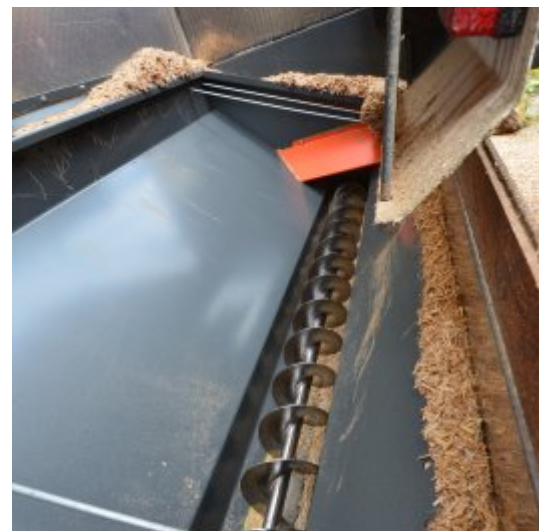
La trémie de livraison Heizotrans à Ourscamp, photo FD
