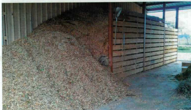
Le silo stocke jusqu'à 80 m 3 de bois, toutes essences confondues, mélangé à des feuilles.
